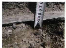
床版上面のコンクリートの土砂化
