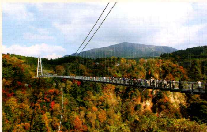
① 吊り橋の下には、筑後川の源流域を流れる鳴子川渓谷の原生林が広がっている
