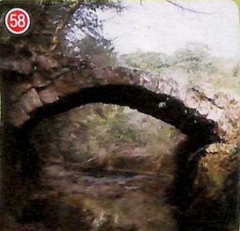
鬼崎スガメ石橋 橋長約5m、幅員1.9mを測る単アーチ橋です。19世紀に架橋されたとも言われ、九州でも極めて古い部類に属します。
