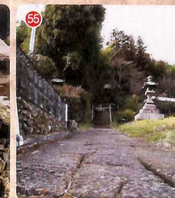
55 皇産霊神社参道 石畳・石段 石畳は幅1.64m、総延長106.6mを測ります。スガメ石という石材を素材とし、建設された年代ははっきりしませんが、中世頃と思われる。
