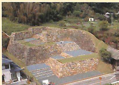
整備終了後の名護屋城跡山里口
