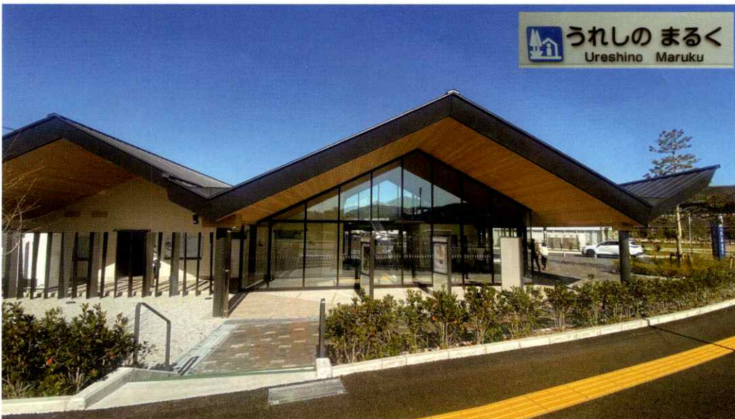
トイレや道路情報・観光情報を提供するモニターを備えた休憩施設
