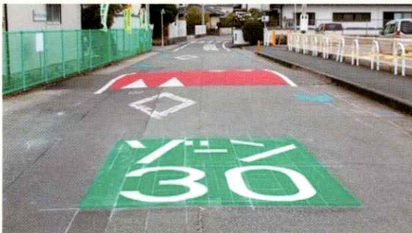
ハンプ設置+ゾーン 30
