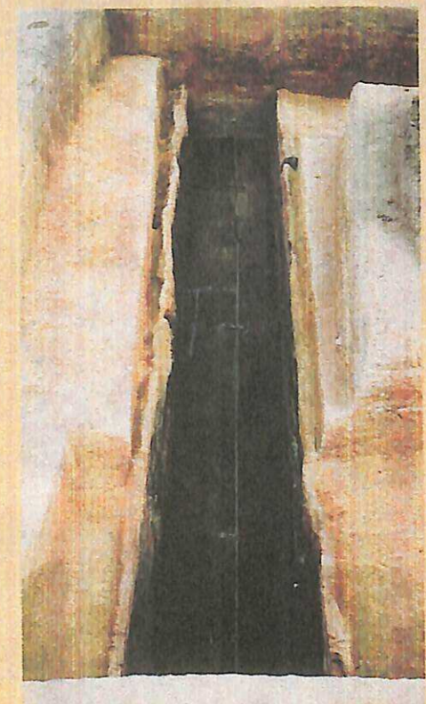
水城大堤木樋の底板
