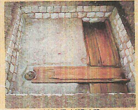
水城大堤 木樋取水部
