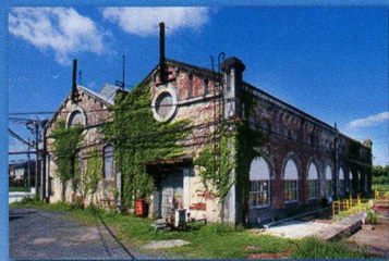
遠賀川水源ポンプ室(中間市)(非公開施設) 写真提供:新日鐵住金(株)八幡製鐵所
