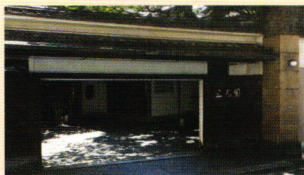
▲木造数寄屋造りの老舗料亭「三光園」。
