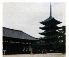
東金堂と五重塔
