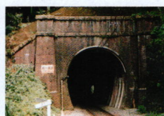
第一真倉トンネル(明治37年)
