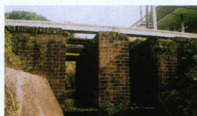
溝渠(真倉、一本杉踏切近く)
