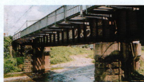
第五伊佐津川橋梁(真倉、伊佐津川) 明治37年
