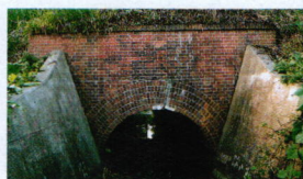
溝渠(円満寺、アーチ)
