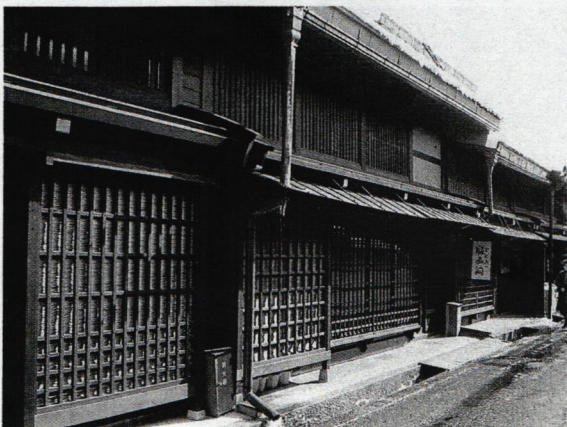
16. 外観(上三之町) 軒の出は深く、下屋を設けず小庇がつく。 小庇の下には日除け庇がある。
