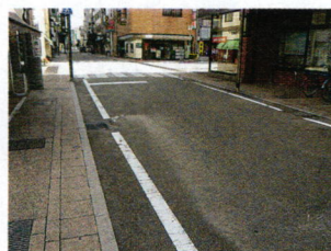
道路の段差解消
