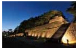
7 金沢城・石垣 日没～22:00 金沢城の威容を今に伝えます。多種多様な石垣を見ることが出来ます。
