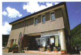
味噌川ダム防災資料館(ふれあい館)
